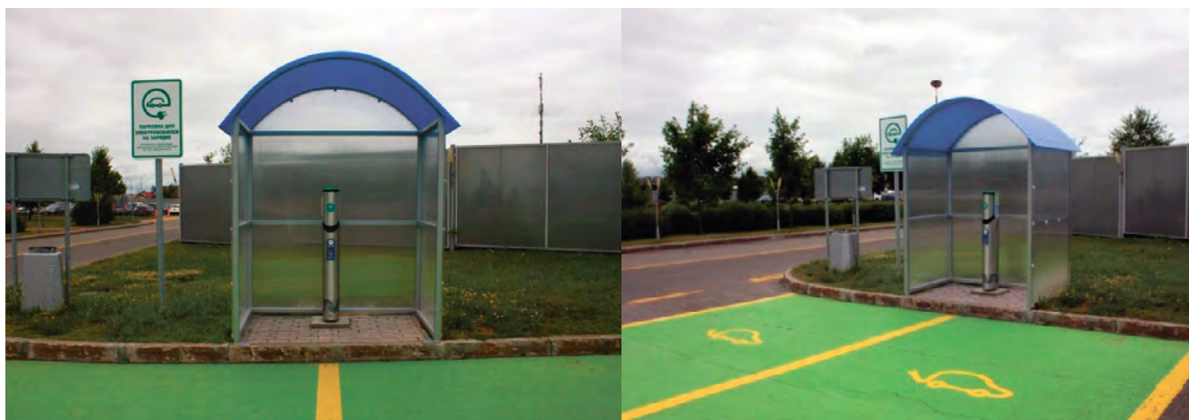
Рисунок 4. Оформление зарядной станции и парковки электромобилей в аэропорту Внуково-3
